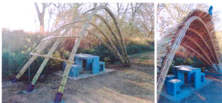
Figures 26 et 27. Pergola ombragée au design paramétrique, composée de quatre arcs formés par des faisceaux de cannes d'environ 15 cm de diamètre et 8 m de longueur. Une série de nervures structurelles permet un tissage traditionnel en canisse avec une corde naturelle, donnant ainsi sa forme et son esthétique finale. Huertos del Prat de Llobregat, Catalogne (Espagne).
