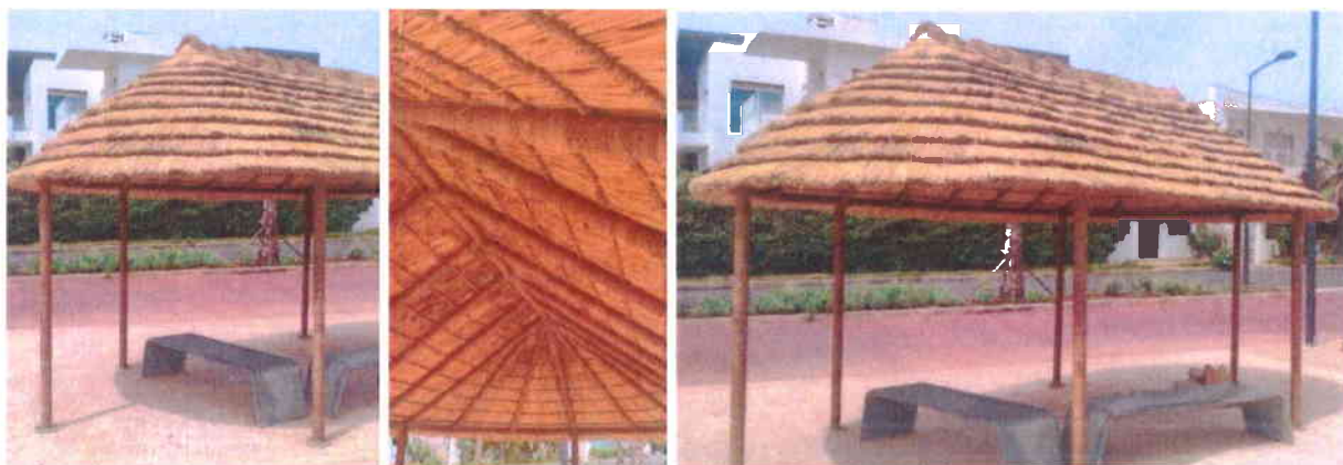
Figures 23, 24 et 25. Exemple de pergola ombragée avec une structure métallique recouverte de corde de raphia et de paille, intégrée au paysage du front de mer de Tamaris, à Casablanca (Maroc).
