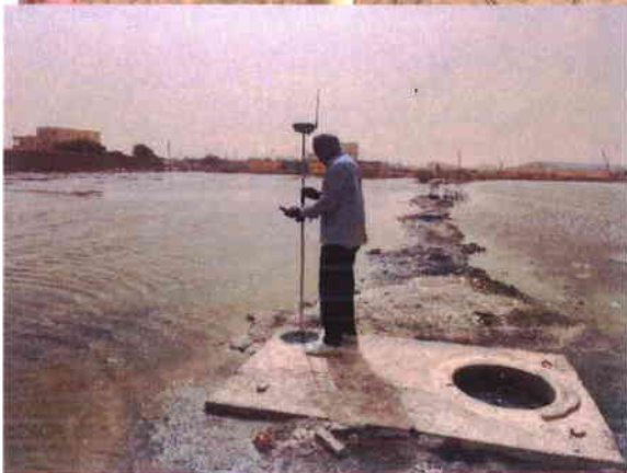
Images 14 et 15. Levé topographique pour la réalisation du Modèle Numérique de Terrain (MNT).
