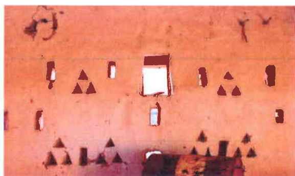
Images 48 et 49 (de gauche à droite). Éléments de décoration et de ventilation traversante dans une maison traditionnelle de Ouadane (Mauritanie), illustrant des techniques architecturales adaptées au climat saharien. Minaret de la mosquée de Chinguetti, emblème de l'architecture traditionnelle de l'Adrar, caractérisé par l'usage de la pierre locale et son intégration harmonieuse dans le paysage saharien.
