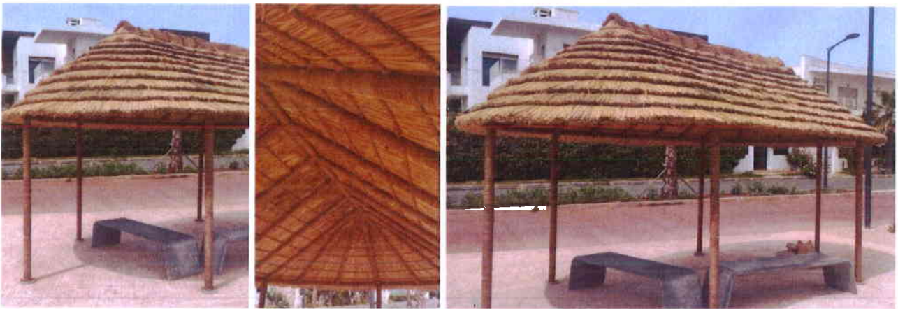
Figures 6, 7 et 8. Exemple de pergola ombragée avec une structure métallique recouverte de corde de raphia et de paille, intégrée au paysage du front de mer de Tamaris, à Casablanca (Maroc).
