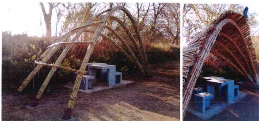
Figures 9 et 10. Pergola ombragée au design paramétrique, composée de quatre arcs formés par des faisceaux de cannes d'environ 15 cm de diamètre et 8 m de longueur. Une série de nervures structurelles permet un tissage traditionnel en canisse avec une corde naturelle, donnant ainsi sa forme et son esthétique finale. Huertos del Prat de Llobregat, Catalogne (Espagne).
